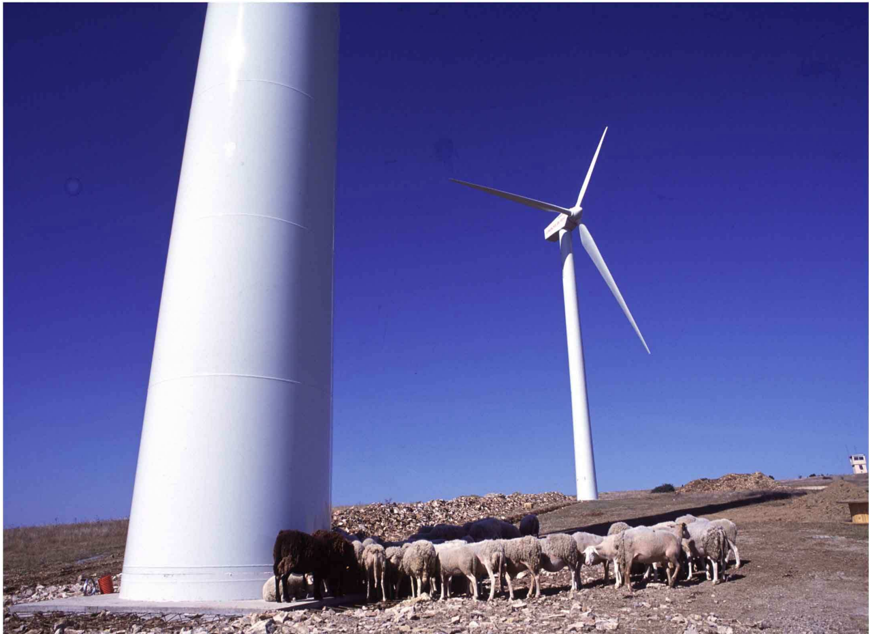
Parc éolien de ROQUETAILLADE, près de Carcassonne, dans l'Aude - Puissance installée : 5,28 MW - Crédit photo ADEME
